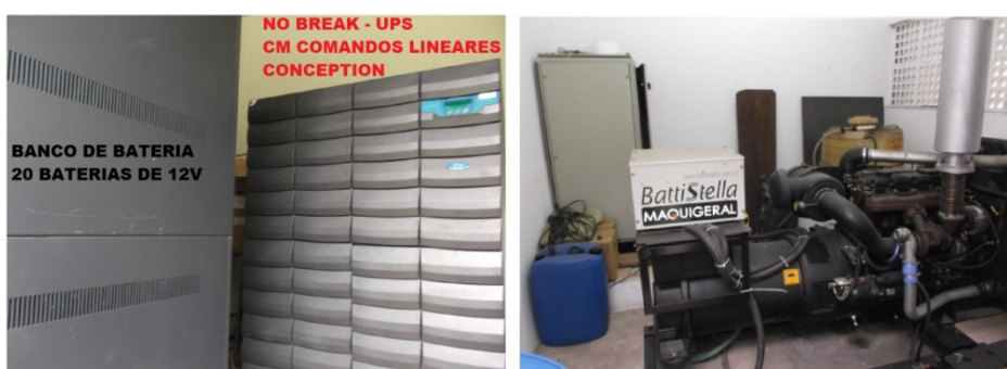
Fig. 1: Espectrômetro de massa alimentado por energia limpa (ups conhecido como no-break). Se houver interrupção de energia externa maior que 5-10 minutos deverá ser suprido por meio do gerador de energia movido a motor diesel, para alimentar banco de bateria (foto lado esquerdo)
